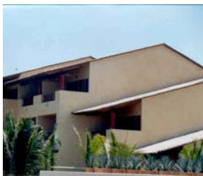
Cubiertas inclinadas con teja.
